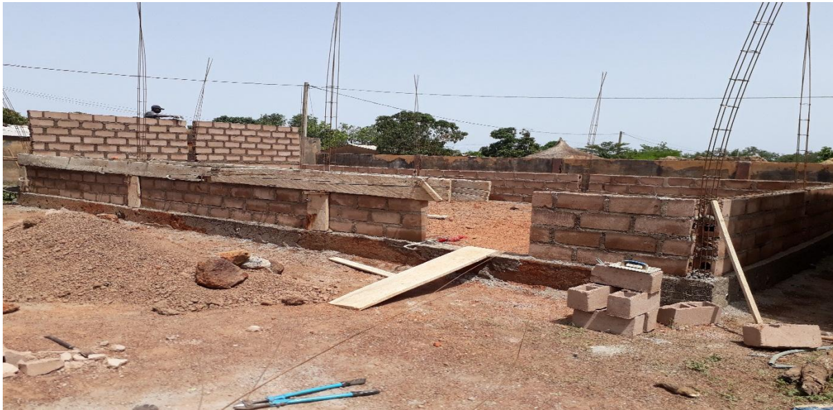
Photo : Chantier de construction de la salle de formation à Keleya
